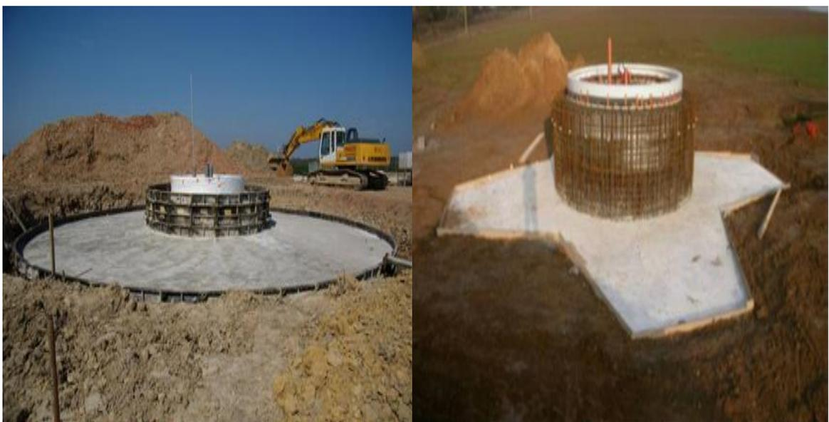
Figure I-2 : La fondation en béton
