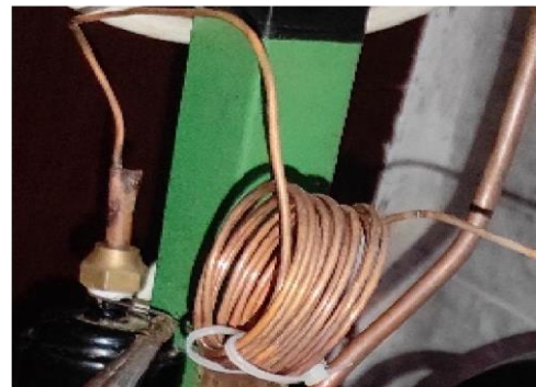
Figure (5.7) : soudure entre le capillaire et le filtre
