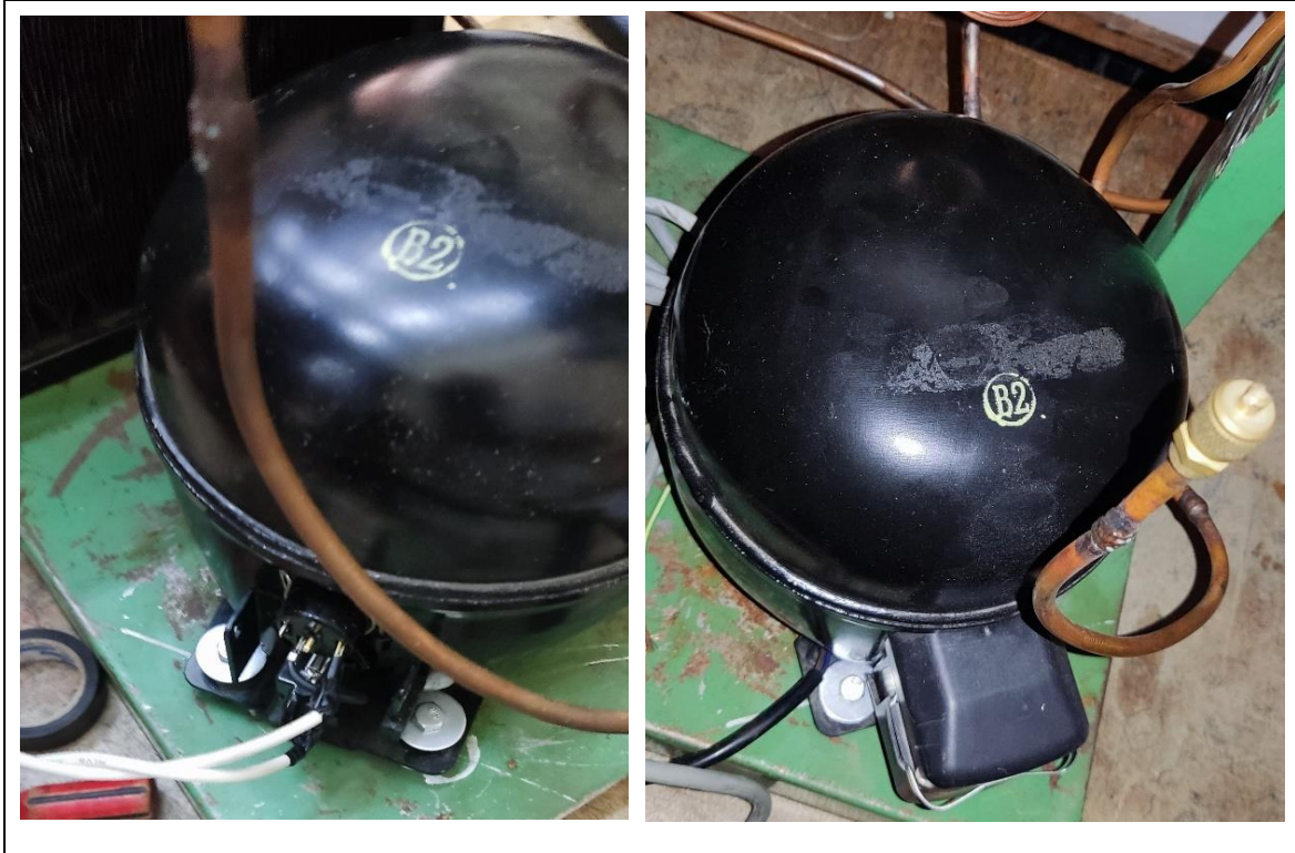
Figure 5-5 : Fixation et câblage du compresseur.
