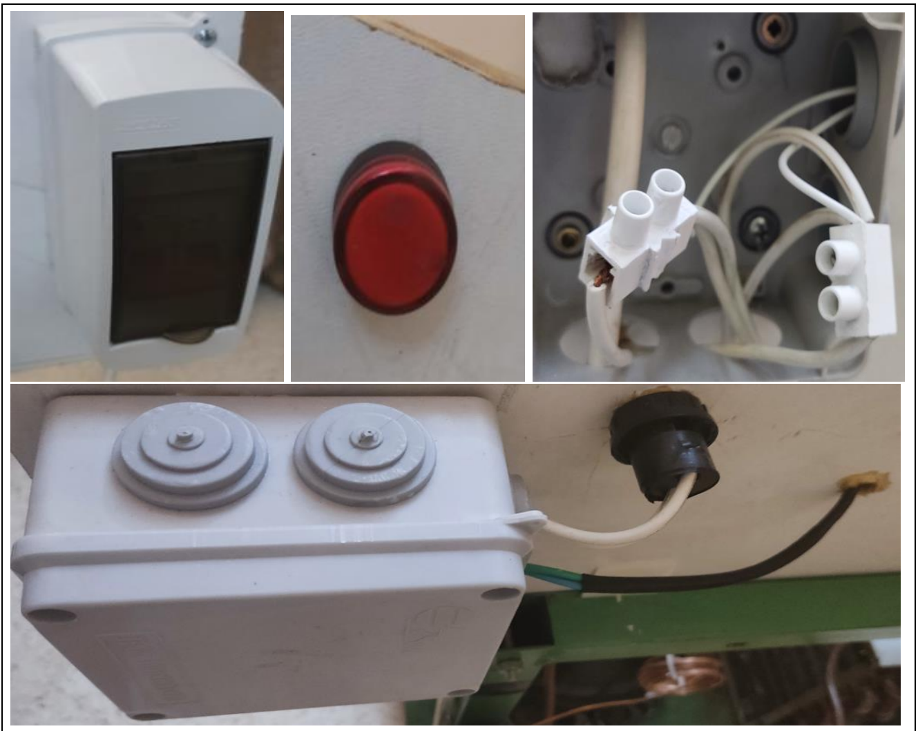
Figure 5-9 : Câblage du système
