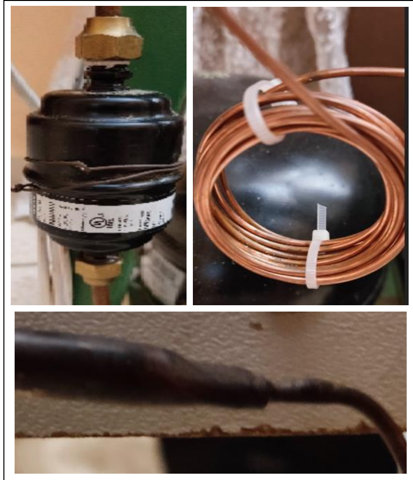
Figure 5-7 : Réalisation du Filtre et du Détendeur.
