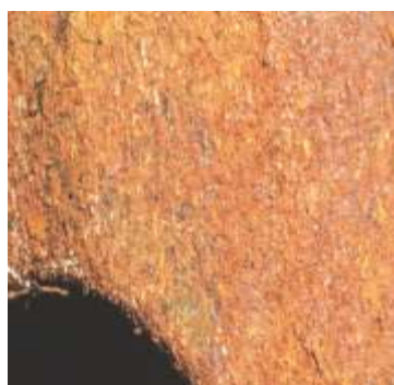
Corrosion généralisée (uniforme).
