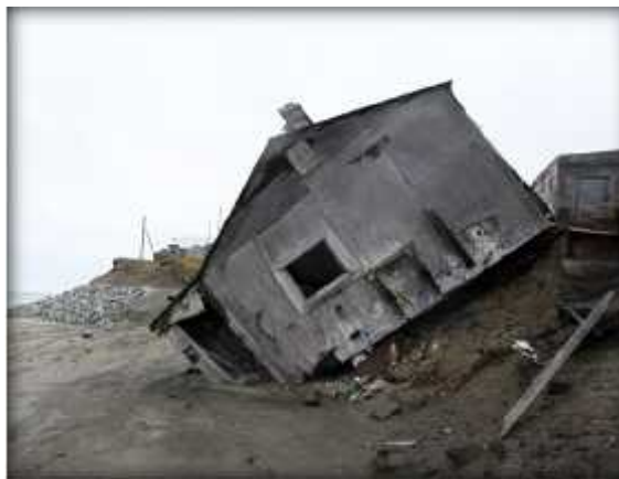
Impact de l'érosion sur le bâti dans le littoral
