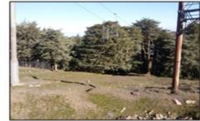
Transport d'énergie électrique
