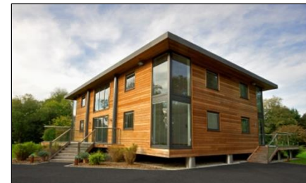
Bardage en bois horizontal
