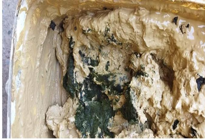
Figure 2.25 : Ajout de bouse de vache durant le second pétrissage ©.
