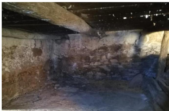
Figure 1.7 : Les poutres sur lesquels repose takanna ©.
