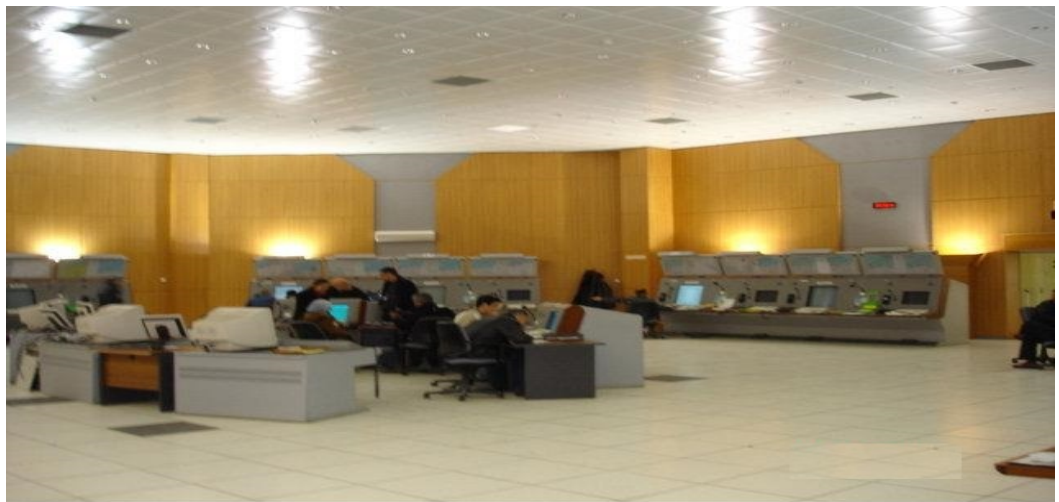
Figure II. 2: La salle de contrôle [16]
