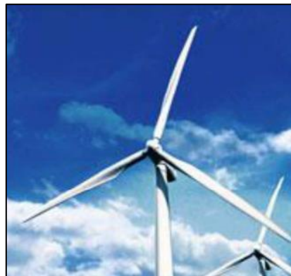
Figure 1.14 : Pales d'éoliennes fabriquées à partir de composites renforcés de fibres de carbone. [57]
