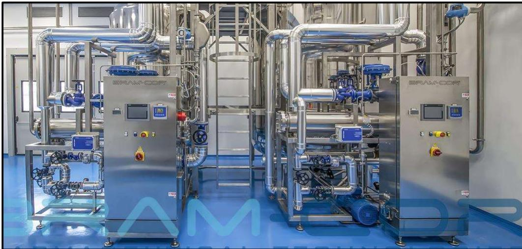
Figure 1-12 : système de stockage et distribution d'Eau Purifiée [9].
