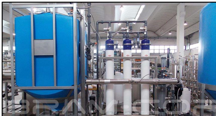
Figure 1-9 : système de prétraitement d'EP [9].
