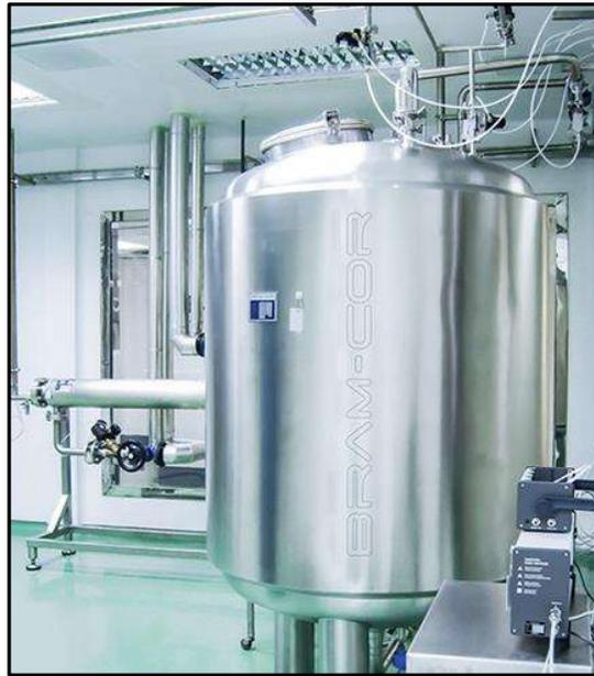
Figure 2-1: Réservoir de stockage d'eau purifiée [9].
