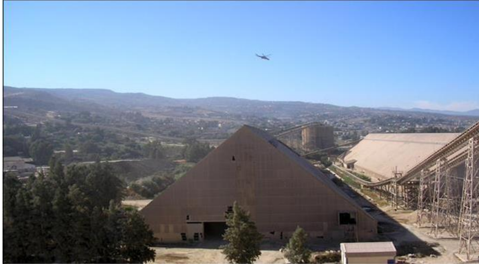
Figure I.6 : Hall de pré homogénéisation.
