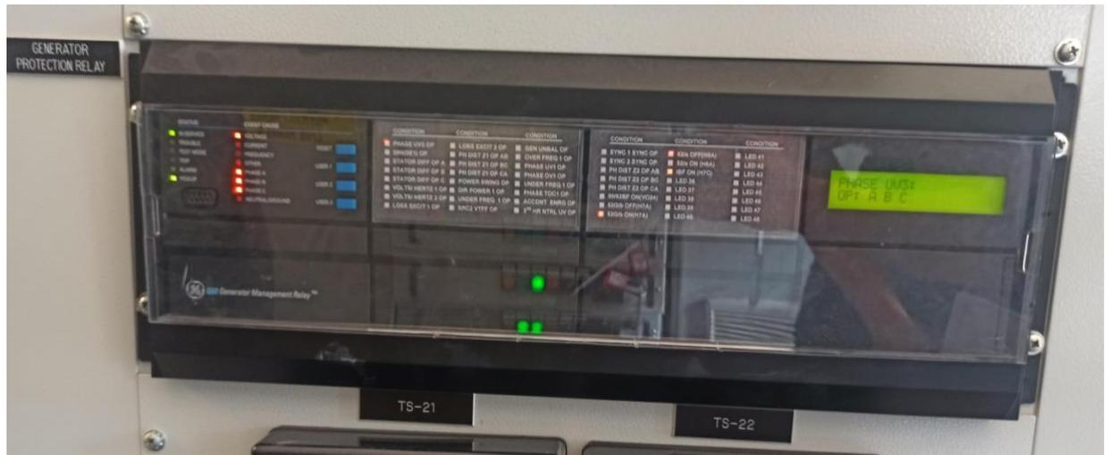
Figure 3.11 :Relais de protection générale dans le centrale de Boufarik 02
