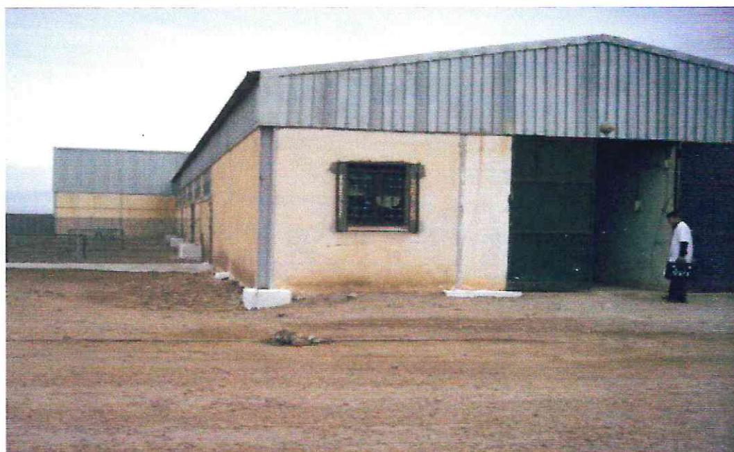
▲ Photo n° 2 : Bâtiment d'élevage des brebis.
