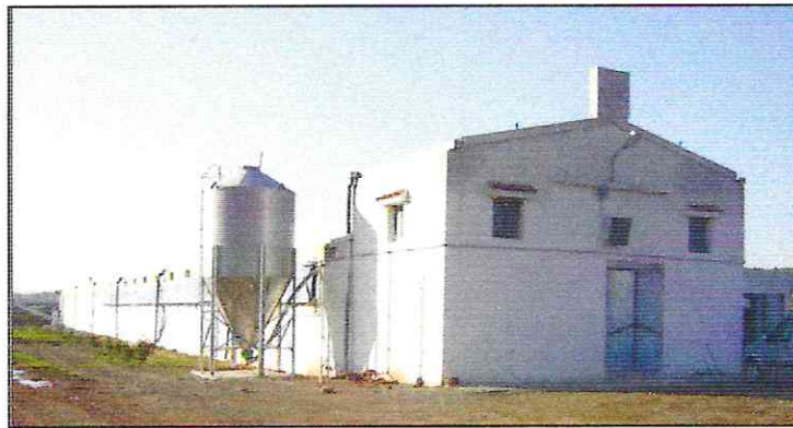
Photo 8 : Bâtiment d'élevage (poussinière)
