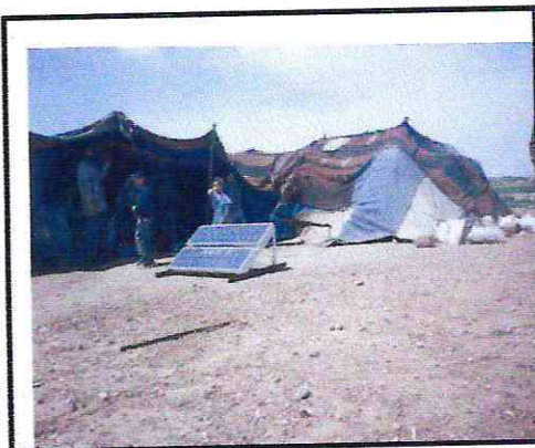
ELECTRIFICATION EN ENERGIE SOLAIRE DES FOYERS ET KHEIMAS
