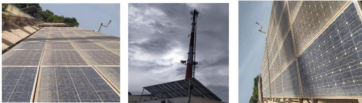
**Figure IV.53 : Poteau du l'ombrage partiel sur le champ PV au CDER**
