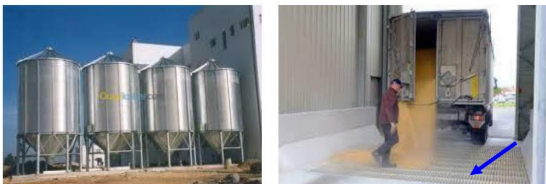
Figure I.6 : des silos de stockage et de la fosse de réception
