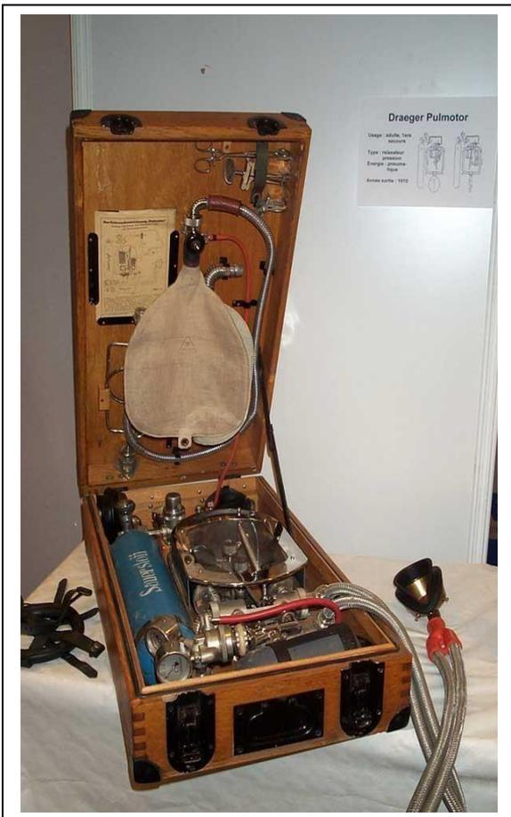
*Figure I.7: Le Pulmotor d'Henrich Dräger 1906[10]*
