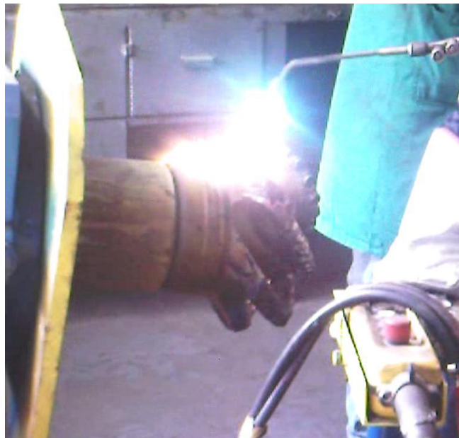
FigII.2 brasage oxyacétylénique des outils de forage prise au sein de l'entreprise ALDIM. [5]
