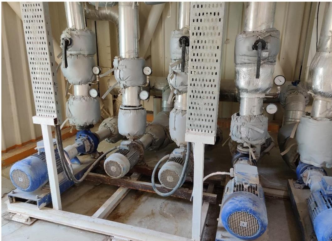
Figure 3.5: les pompes de systèmes CVC d'usine HAYAT DHC
