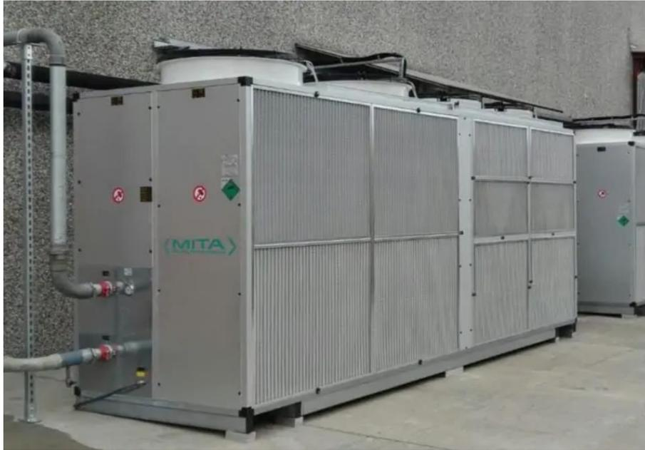
Figure 2.4: Refroidisseur sec ou à air [7]
