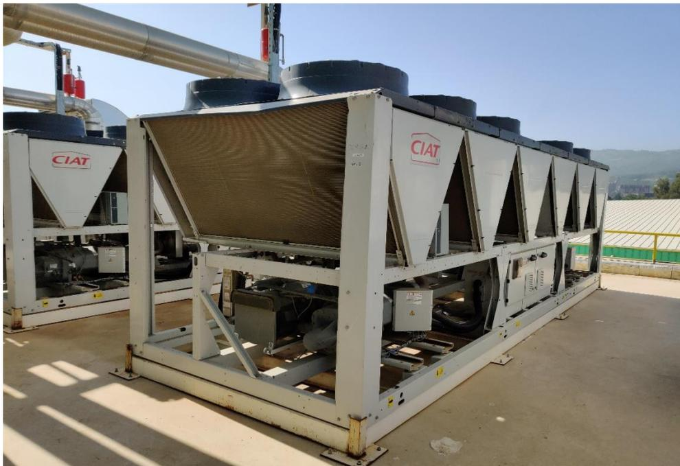
Figure 3.4: refroidisseur d'eau d'usine HAYAT DHC (CIAT)
