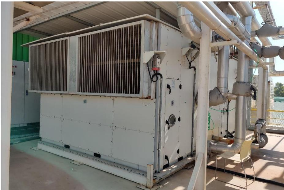
Figure 3.7: Unité de traitement d'air (AHU)
