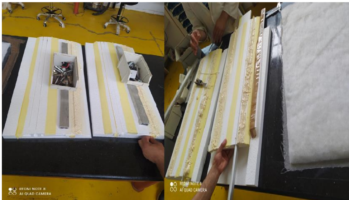
Figure IV-30 fermer les vides causés par le fil chaud par la mousse.
