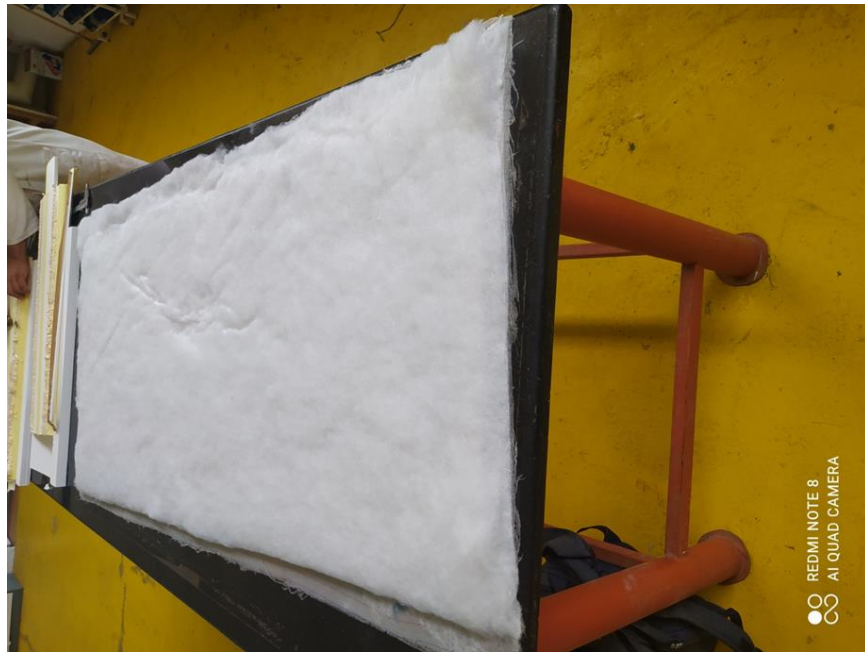
Figure IV-18 Posons le feutre de drainage.
