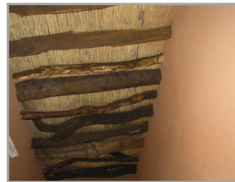
Figure43 : Plancher traditionnel de bourg avec des éléments traditionnels
