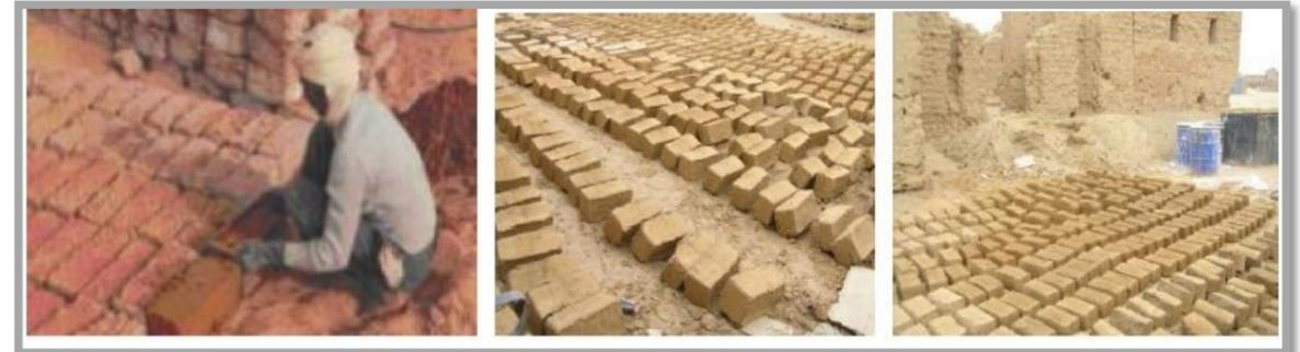
Figure59 : moulage des briques en terre
