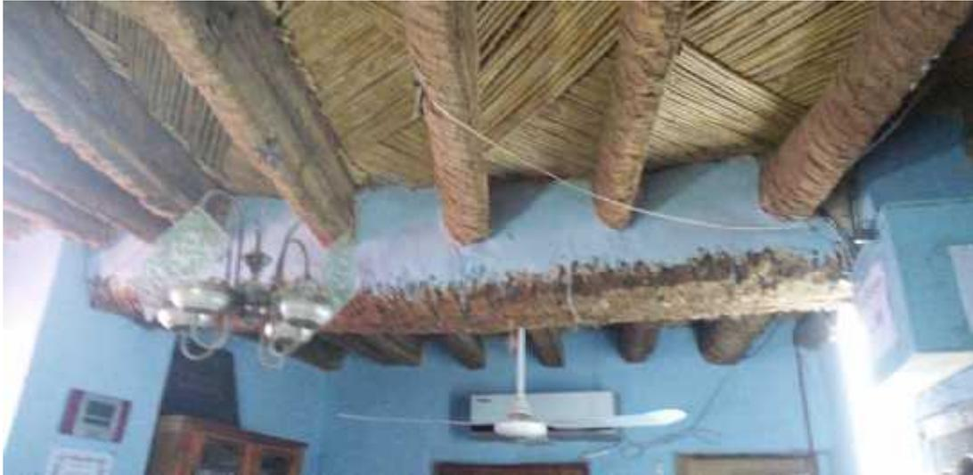
Fig.22 : plancher d'une salle de prière (avec tige et troncs de palmiers).
