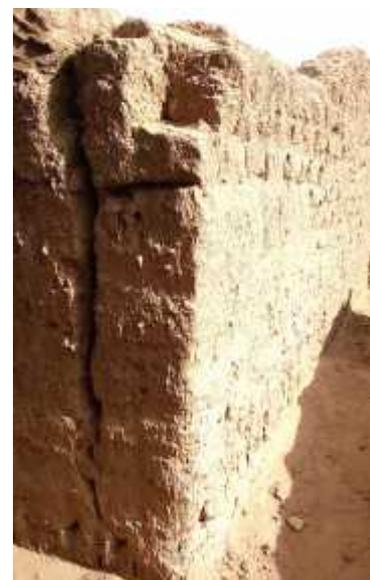
Figure 3.8 n5 : Fissuration due au gonflement, maison d'El-Kandossi.
