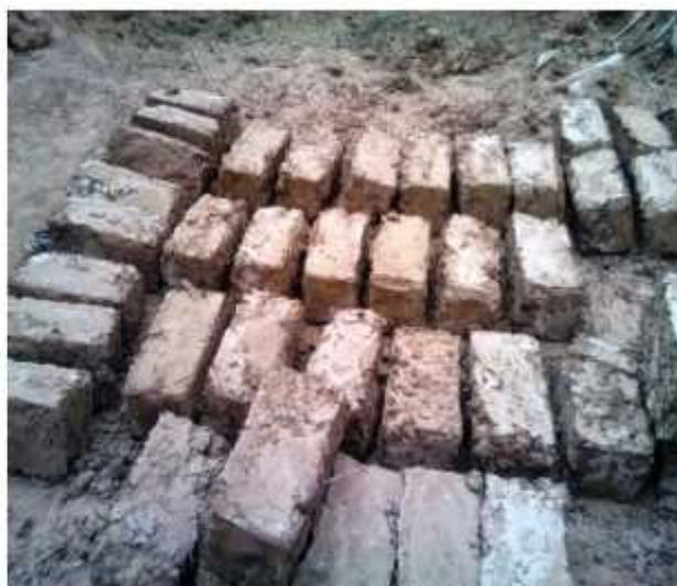
Fig.21 : Briques de terre crue séchée.
