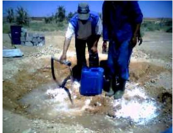
Fig.18:préparation du mortier.
