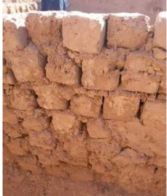
Fig.15: mur construit en adobe.
