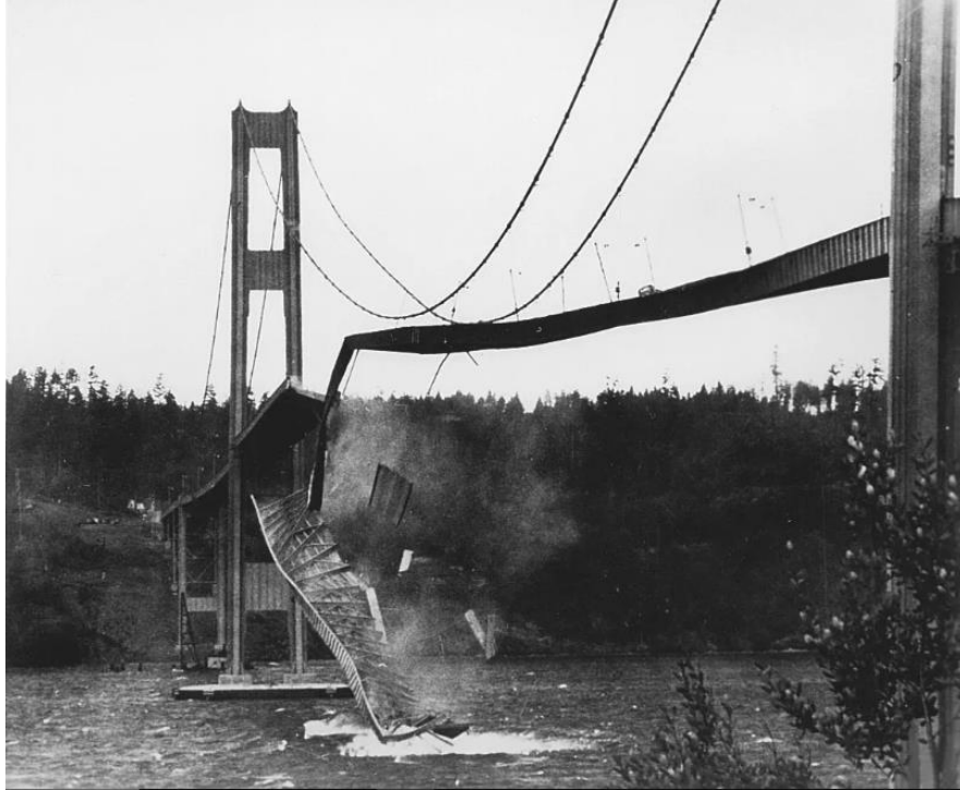
Figure I-2 : La destruction du pont de Tacoma, Washington, 1940
