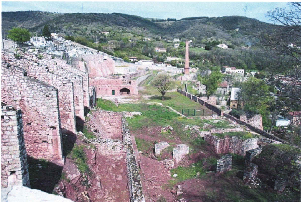
Photo 3 : Anciens hauts fourneaux (Rhône, France) Témoins archéologiques d'une activité industrielle passée.
