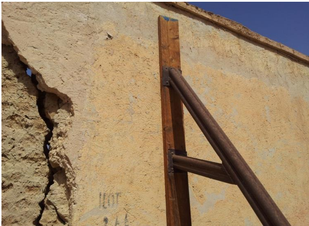
Fig 63 : une photo qui montre les travaux de l'étaieiment a l'extérieure sur la mosquée Koubba EL KHADRA en 2014
