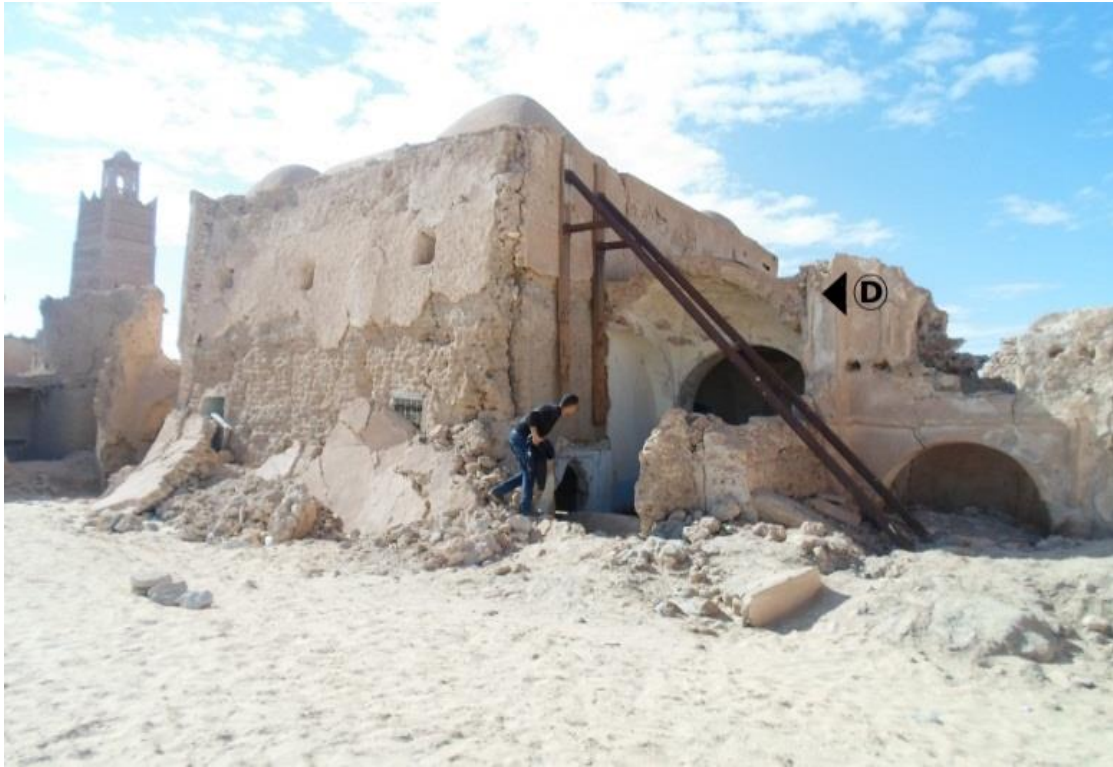
Fig 62 : une photo qui montre les travaux de l'étaieiment a l'extérieure sur la mosquée Koubba EL KHADRA en 2014
