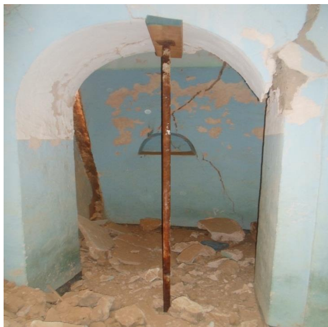
Fig 59 : une photo qui montre les travaux de l'étalement a l'intérieur sur la mosquée Koubba EL KHADRA en 2013
