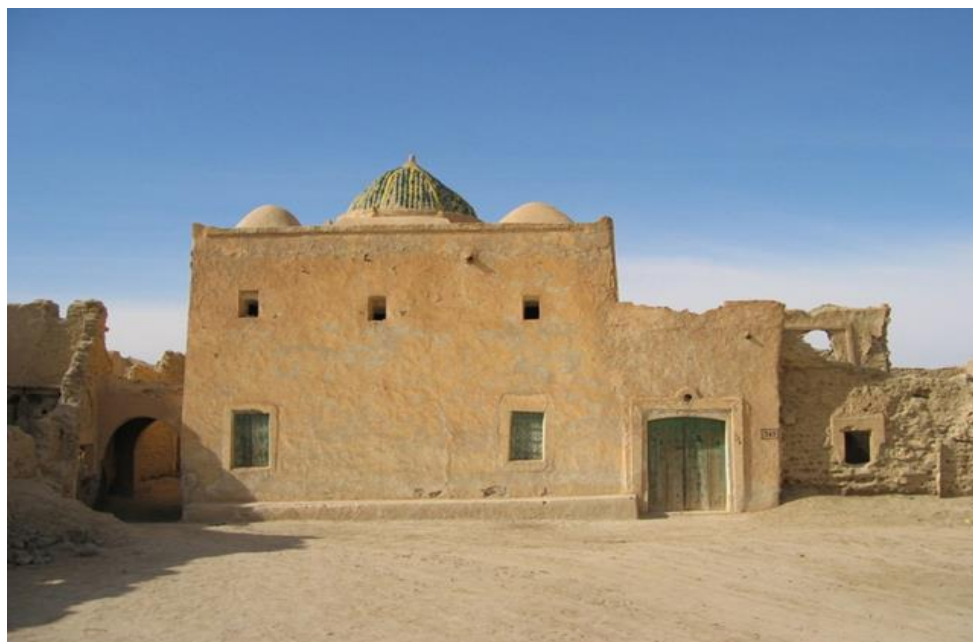
Fig 26 : une ancienne photo de la mosquée Koubba EL KHADRA
