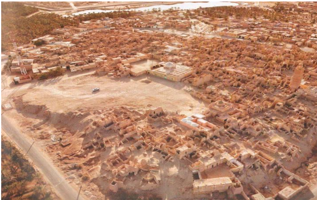
Fig 21 : une vue aérienne du Ksar de Temacine
