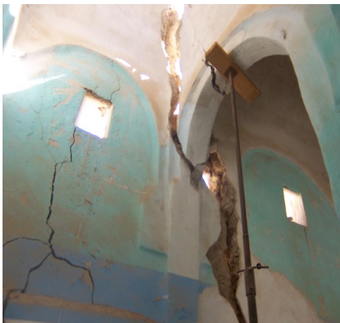
Fig 58 une photo qui montre les travaux de l'étalement a l'intérieur sur la mosquée Koubba EL KHADRA en 2013
