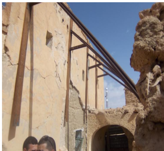
Fig 61 : une photo qui montre les travaux de l'étalement a l'extérieur sur la mosquée Koubba EL KHADRA en 2014
