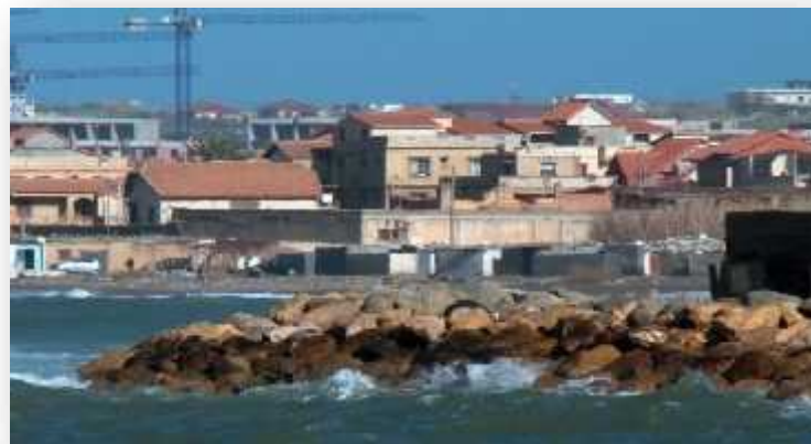
Figure 3.9. « Photos prise sur Bordj El bahri près d'El Marsa par l'auteur ».
