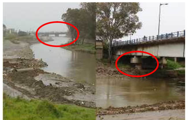
Figure 3.25. Passage piéton existant sous pont
