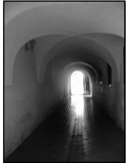
Voûter d'arêtes surtout dans les Rez de chaussée les portiques ; le sas d'une porte d'entrée d'un palais.
