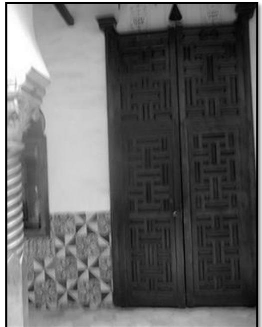
*L'axe des portes et des fenêtres de toutes les pièces sur patio ne se trouve jamais en prolongement avec l'axe d'une colonne mais toujours entre deux colonnes, ainsi, la vue à partir de l'intérieur de la pièce n'est jamais obstruée par un obstacle.*
