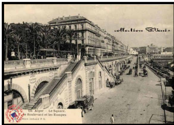
Figure 37 : escalier du Square.
