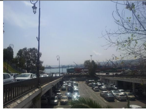
Figure 51 : le parking sous les rampes de Tafourah
