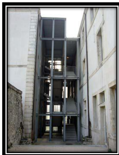
Photo 20 : structure métallique verticale
