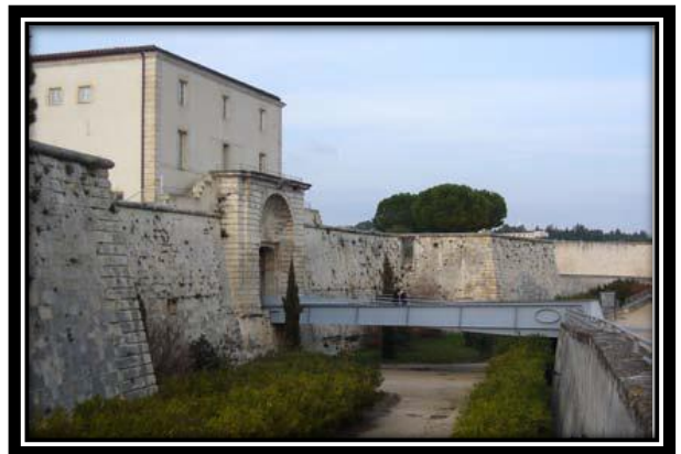
Photo 15 : La passerelle métallique
