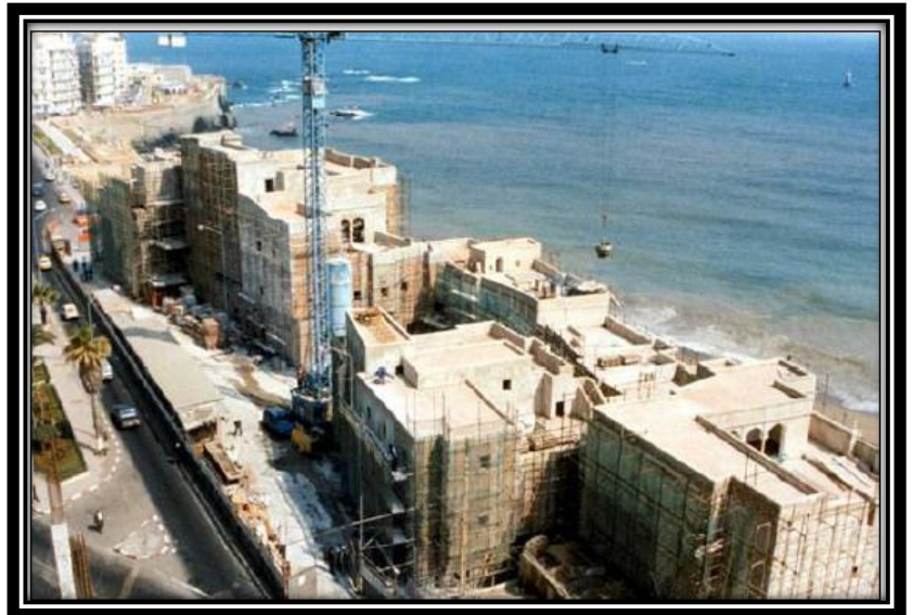
Photo 25 : Bastion 23 lors de la restauration
