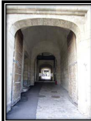
Photo 18 : accès à la cour
