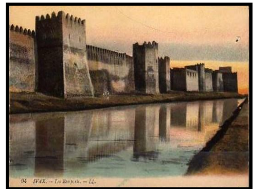
Photo01 : La Tranchée du Sfax.
