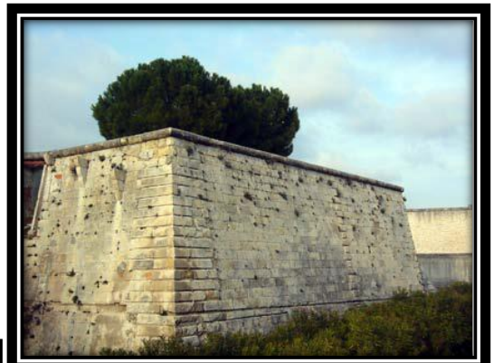
Photo 7 : maçonnerie d'un mur du fort
