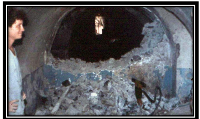
Photo 26 : Nettoyage du bastion 23
