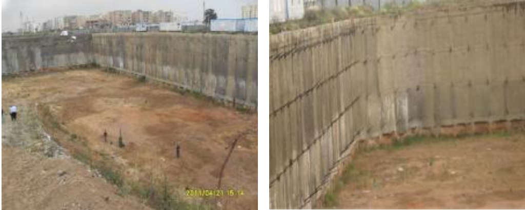
-Soutènement du projet d'Air Algérie à Alger (H=15m)-
