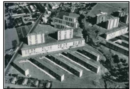
Figure 3.15 : Vue sur l'ensemble des logements
