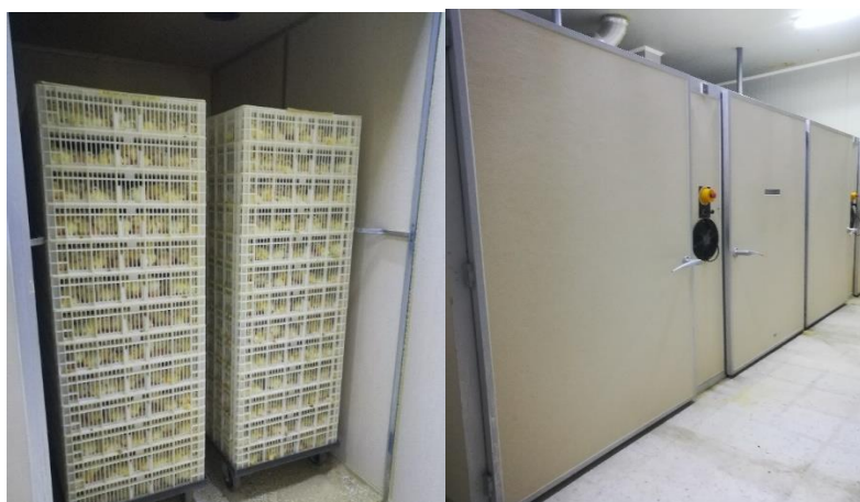
Figure 10 : Salle des éclosiers
