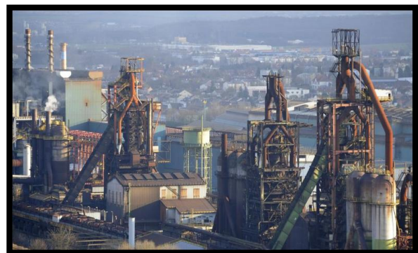
Figure 6 : friches industrielles au centre ville
