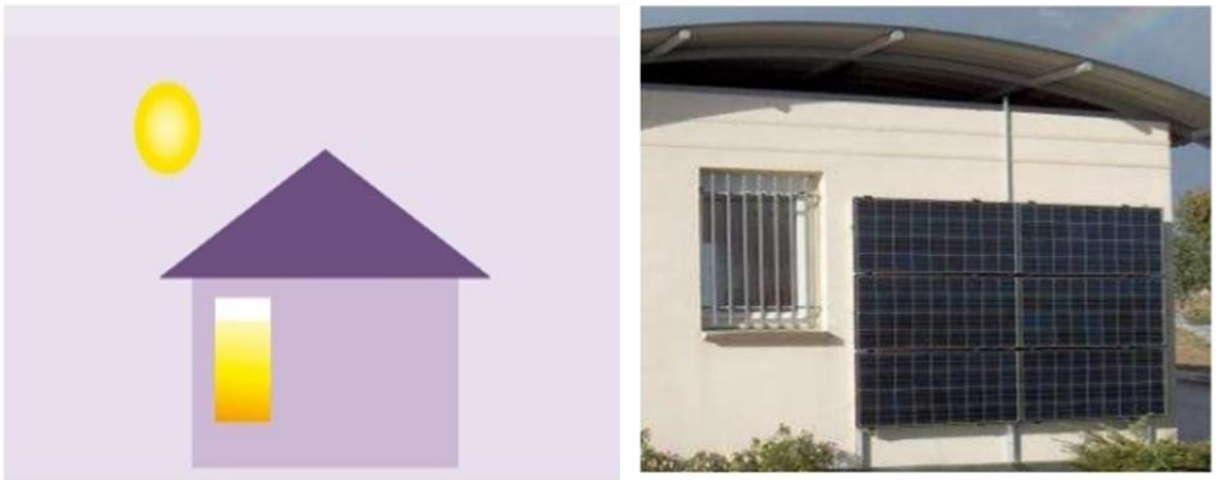
Figure II.12 : Intégration des capteurs solaires sur les allèges
