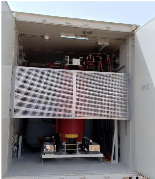
Figure 2-16 : Coté transformateur élévateur.
