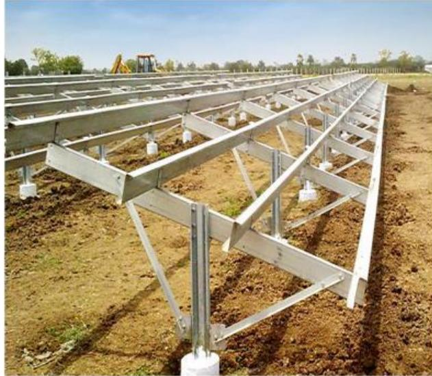
*Figure 1-7 : Exemples de structures porteuses.*
