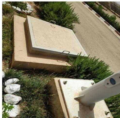
Figure 2-40 : Poteau et kit de l'éclairage public solaire photovoltaïque.
