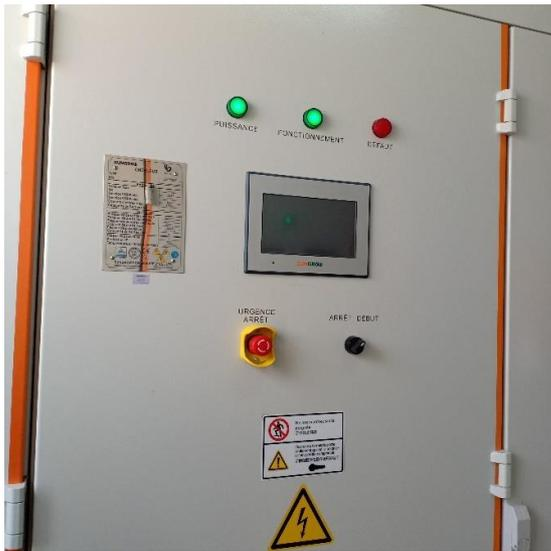
Figure 2-11 : Afficheur de l'onduleur
