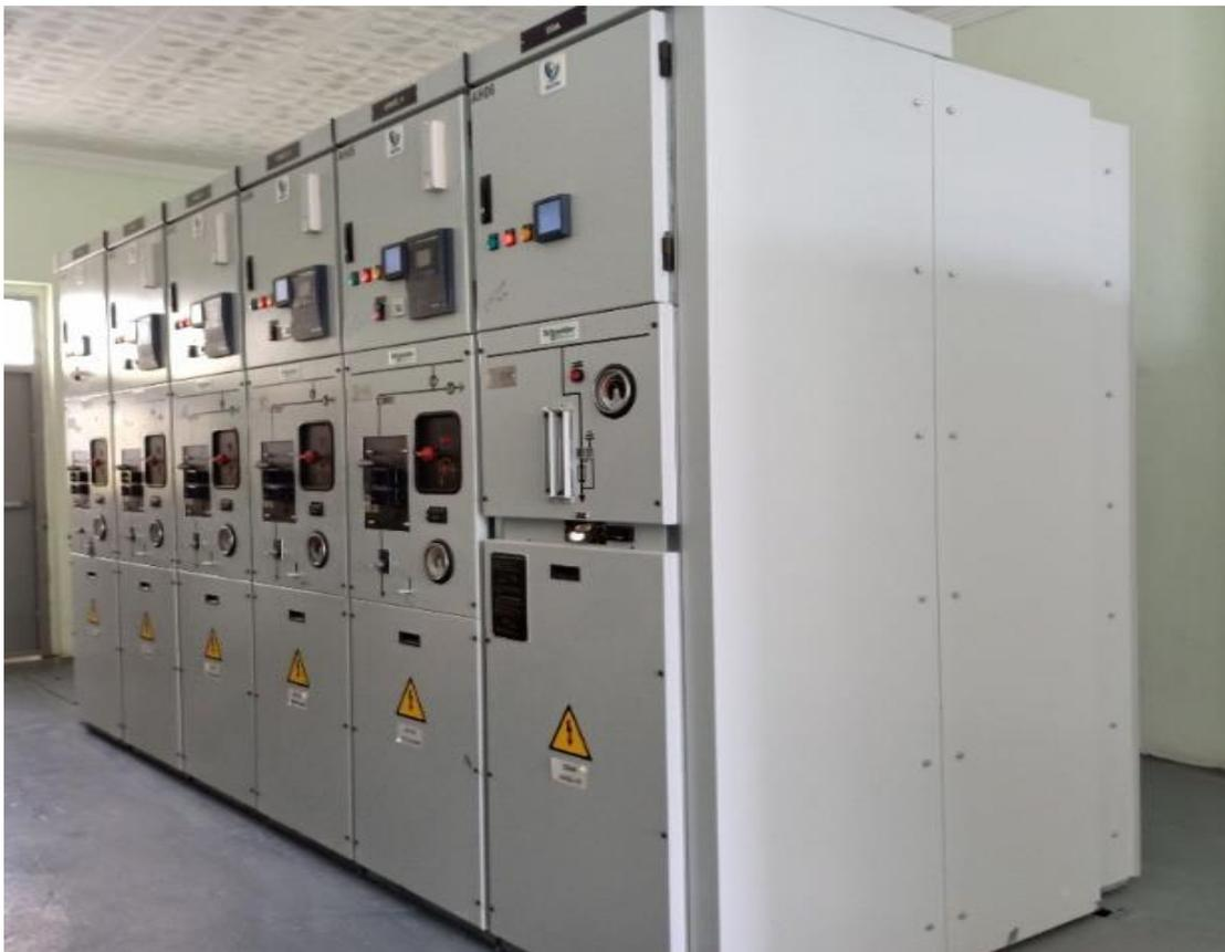
Figure 2-19 : Les arrivées et le départ du poste d'évacuation MT.
