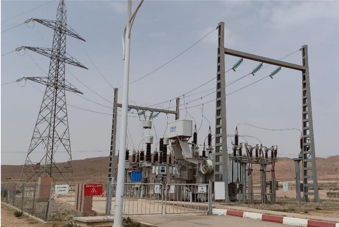
Figure 2-22 : Local de transformateur éleveur 60KV.
