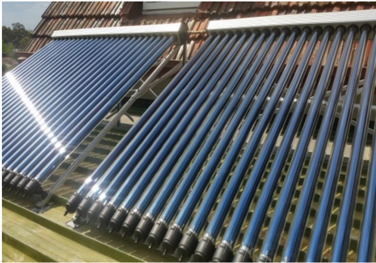
Figure 1-10 : Un capteur solaire à tube sous vide.
