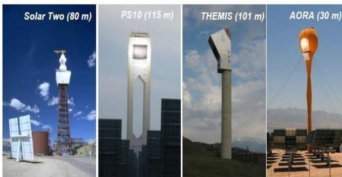
Figure III. 12: Exemples de tours de centrales solaires[32].
