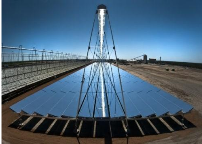
Figure III. 2: Centrale solaires linéaires de Fresnel[23].
