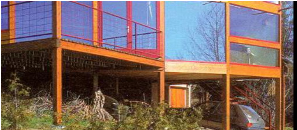
Figure 1-16 Deux murs capteurs sont intercalés entre les fenêtres au sud (arch.R. Marlin).
