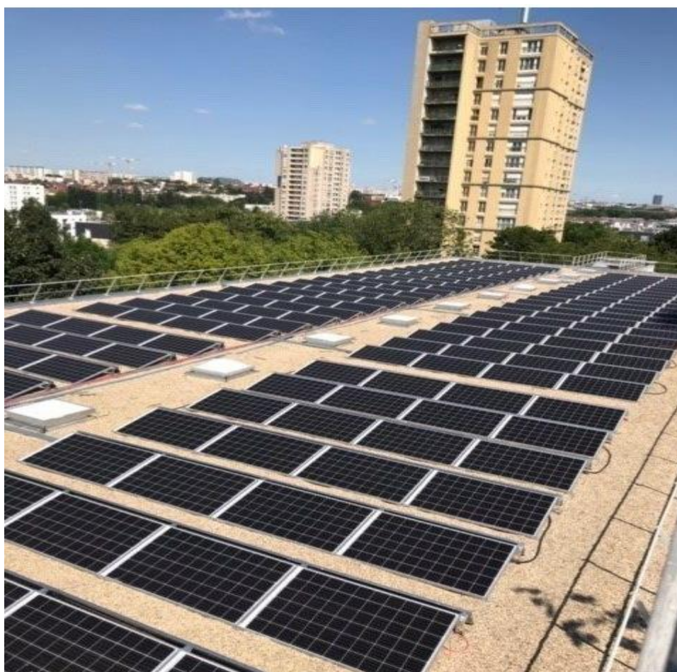
Figure 2 9: Construction rapportée sur bâtiment
