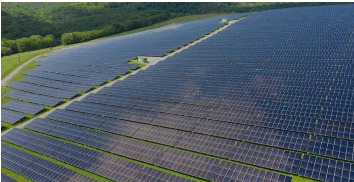
Figure 2 8: construction sur le terrain
