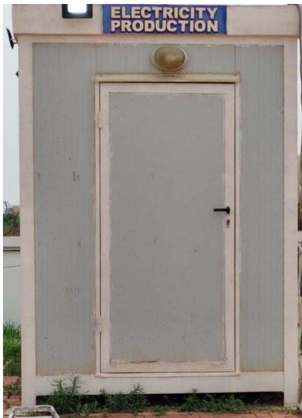
Figure IV. 1: Vu extérieure de la salle de mesure.
