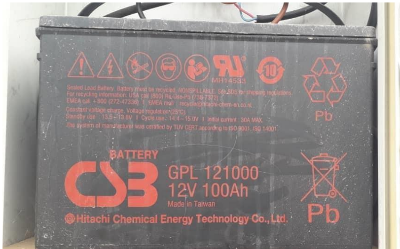
Figure (III-9): batterie CSB GPL 121000
