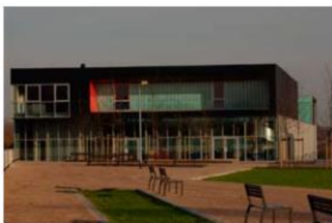
La Halle de glisse Antoine Béal, Ludovic Blanckaert architectes © Fonds SCIM
