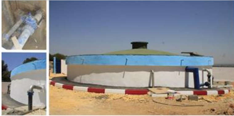
Fig.III 5. Réservoir de VSA Berbessa 500 m 3
