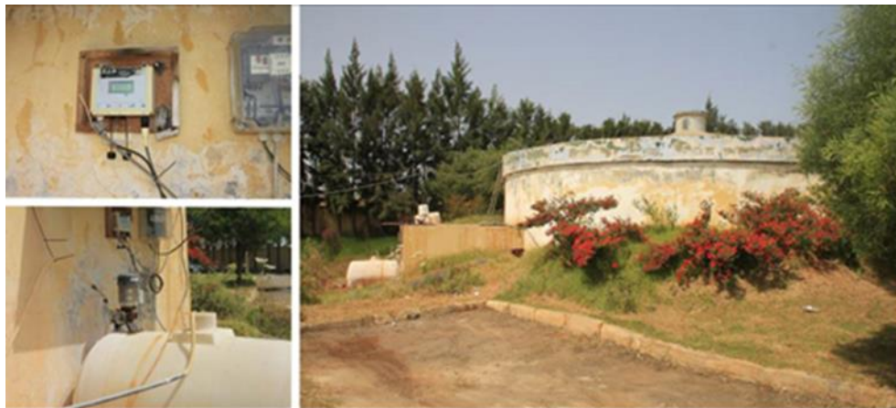
Fig.III 8. Réservoir SP Berbessa 500m 3
