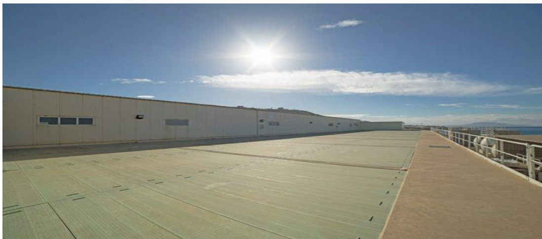
Figure III.9 : Les filtres à sables de la station de dessalement de Fouka.
