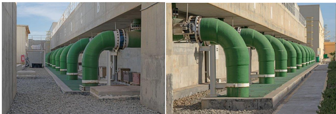
Figure III.8 : Les pompes de filtration à sable.
