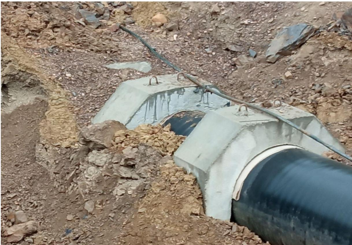
Figure V-4 : Cavaliers en béton placée (Cliché par Khalil le 26.05.2022)
