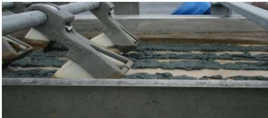
Figure II.18: Déshydratation des boues [19]
