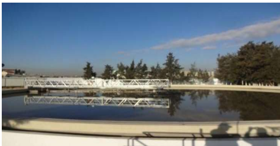
Figure III.8: Décanteur primaire de la STEP de Béni Mered Source : [STEP de Beni Mered]
