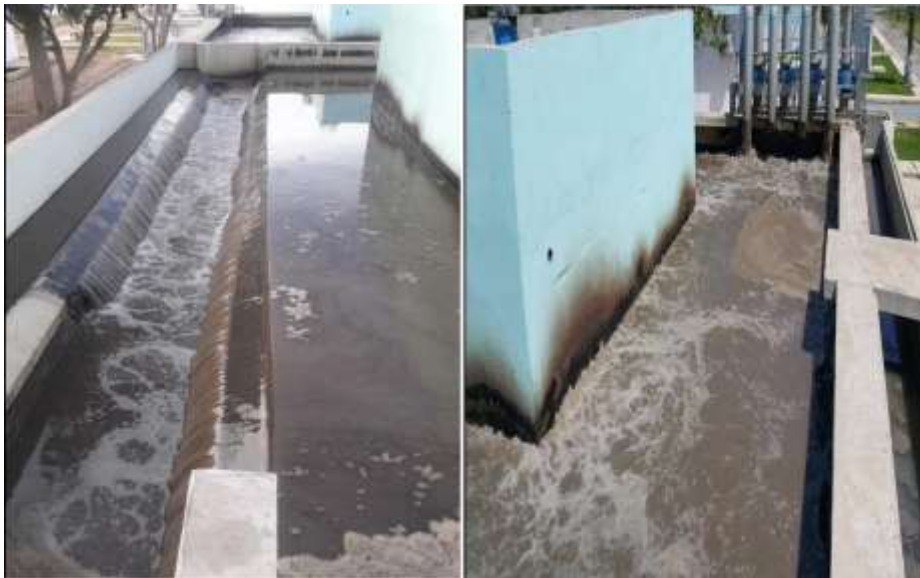
Figure III.9: Bassin d'aération de la STEP de Béni Mered Source : [STEP de Beni Mered]
