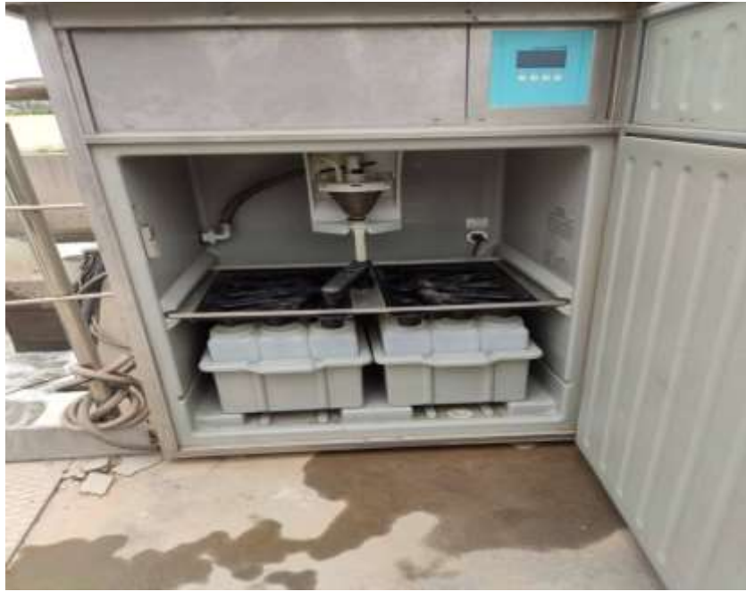
Figure IV.1: Préleveur automatique Source : [STEP de Beni Mered]
