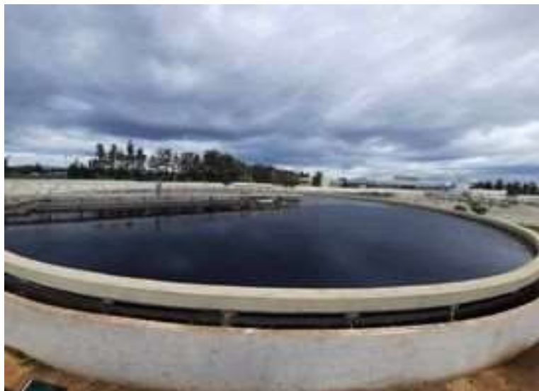
Figure III.10: Clarificateur de la STEP de Béni Mered Source : [STEP de Beni Mered]
