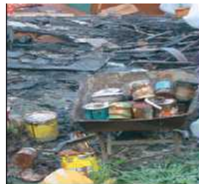
Figure 2.10 : Déchets toxiques de chantier
