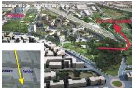
Figure 46 :Jardin-passerelle d'accès au parc Angeletti
