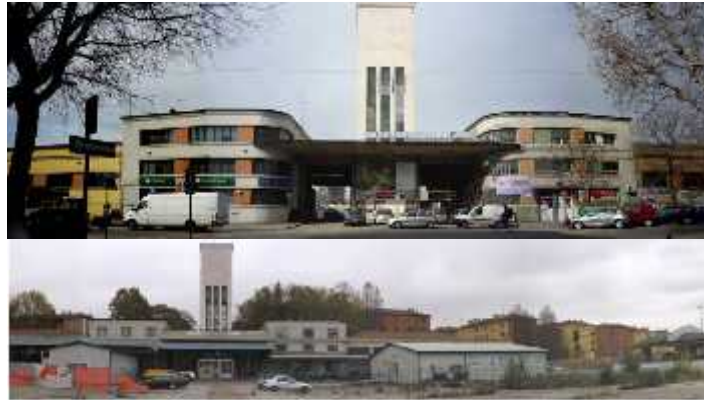
Figure 36 : Vues du marché après la démolition amorcée par le projet en cours, en 2007 : la tour d'entrée est sauvegardée
