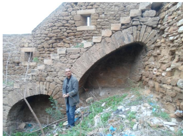
Crédit photo : la muraille de Mostaganem de l'intérieur, vu sur les escaliers et le chemin de ronde Source, personnelle
