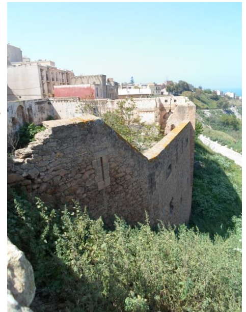
Crédit photo : les remparts de Mostaganem. Source, personnelle
