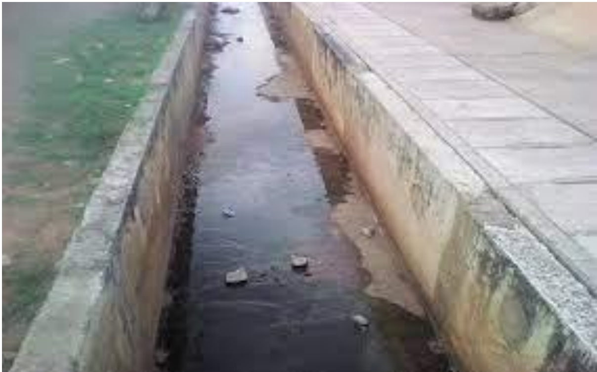
Figure IV. 3 Caniveau à ciel ouvert
